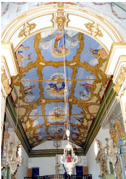
FIGURA 04: Arco-cruzeiro, cimalha e teto da nave da Matriz repintados. Fotografia: acervo da Paróquia de N. S. da Conceição, Prados-MG s/d.
