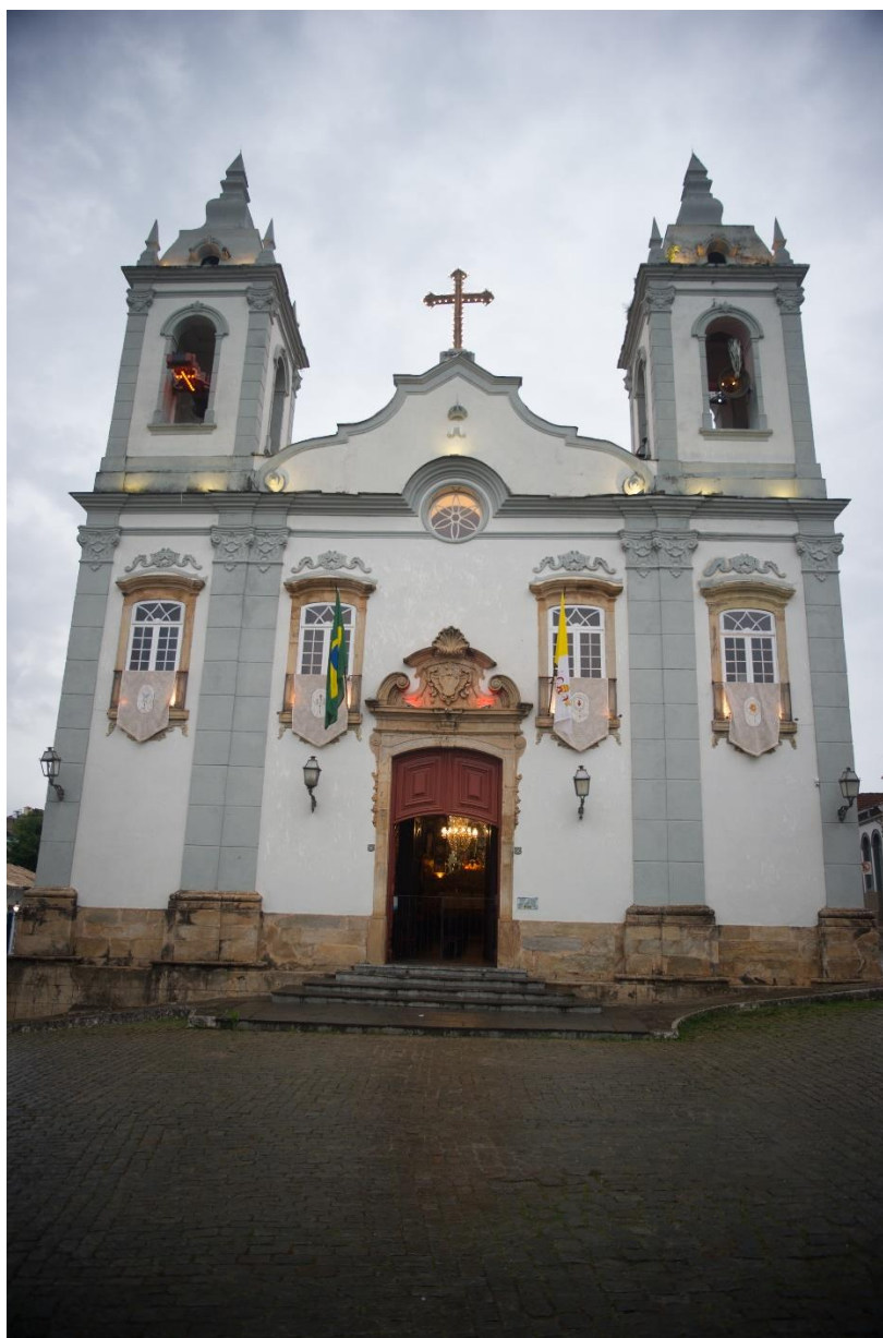
[Fig. 2] – Fachada da Capela de Nossa Senhora do Rosário dos Homens Pretos, século XVIII. Fotografia de Marcos Luan C. Barbosa.
