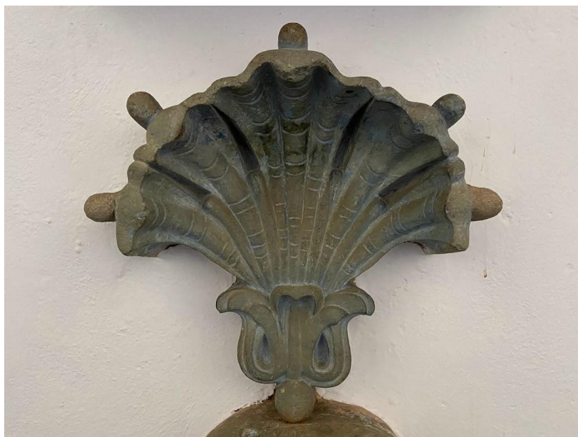
[Fig. 23] – Detalhe do resquício de tinta azul na carranca do lavatório da Capela de Nossa Senhora do Rosário dos Homens Pretos, São João Del Rei/ MG. Fonte: Fotografia do autor.
