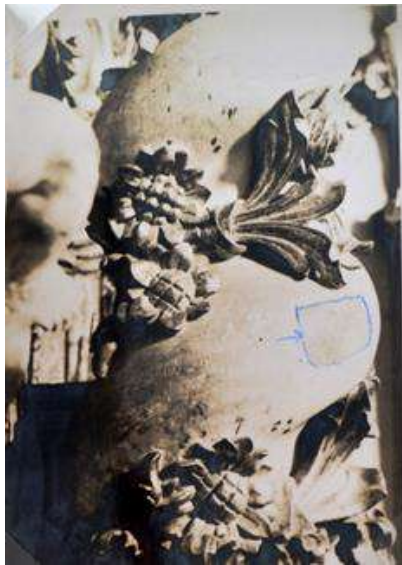
[Fig.9] Janela de prospecção e teste de remoção de pintura de cor branca sobreposta à policromia da coluna do retábulo-mor. Fonte: XAVIER FILHO, Geraldo Francisco. Relatório do trabalho de Restauração feito na Catedral de Nossa Senhora do Pilar em São João del Rei/Minas Gerais . [ACI-RJ] / Série CRBC / Caixa s/número]. IPHAN. São João del-Rei, 1971.
