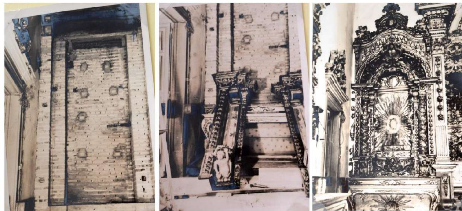
[Fig. 7] Fotomontagem: 1- Colunas de tijolos e viga de cimento já prontas. 2 - Início da remontagem do retábulo de N. Sra. da Boa Morte. 3 - Retábulo de N. Sra. da Boa Morte remontado após restauração completa. Fonte: XAVIER FILHO, Geraldo Francisco. Relatório das fotografias do altar de Nossa Senhora da Boa Morte da Catedral de Nossa Senhora do Pilar em São João del-Rei/Minas Gerais . [ACI-RJ / Série CRBC / Caixa s/número]. IPHAN. São João del-Rei, 1970.
