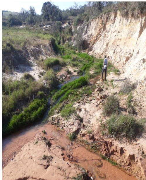
Figura 01 - Voçoroca Oliveira – 22/06/2019. Fonte: Foto do autor.
