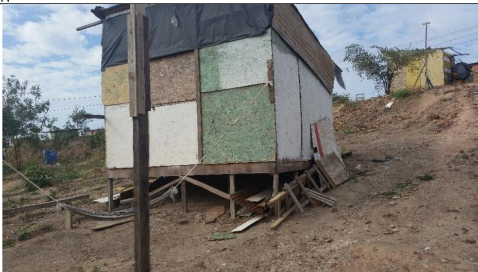
Figura 2 – Moradias instaladas em encosta e topo de encosta.
