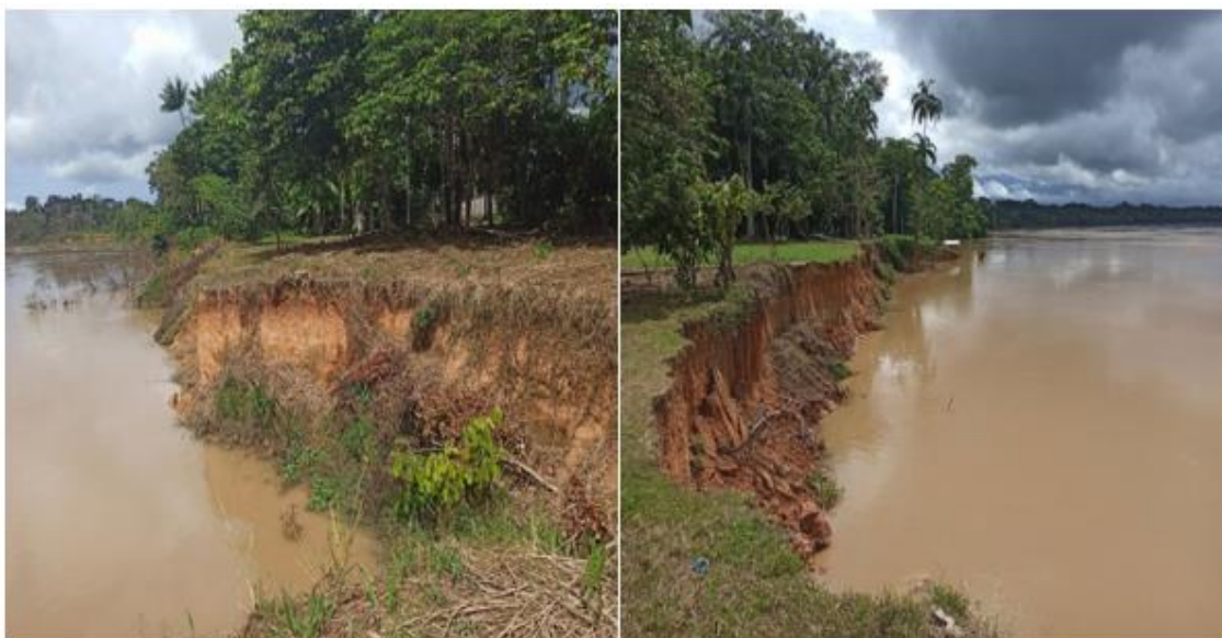
Figura 7 - Fenômeno de Terras Caídas, comunidade Canta Galo. Fonte: Autores, 2024.
