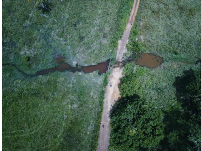
Figura 5 - Canal de drenagem de ordem 1 em franco processo de assoreamento devido às pressões antropogênicas de supressão de cobertura vegetal de áreas de cabeceiras de drenagem e de retirada de vegetação ciliar no município de Vila Nova dos Martírios (MA).
