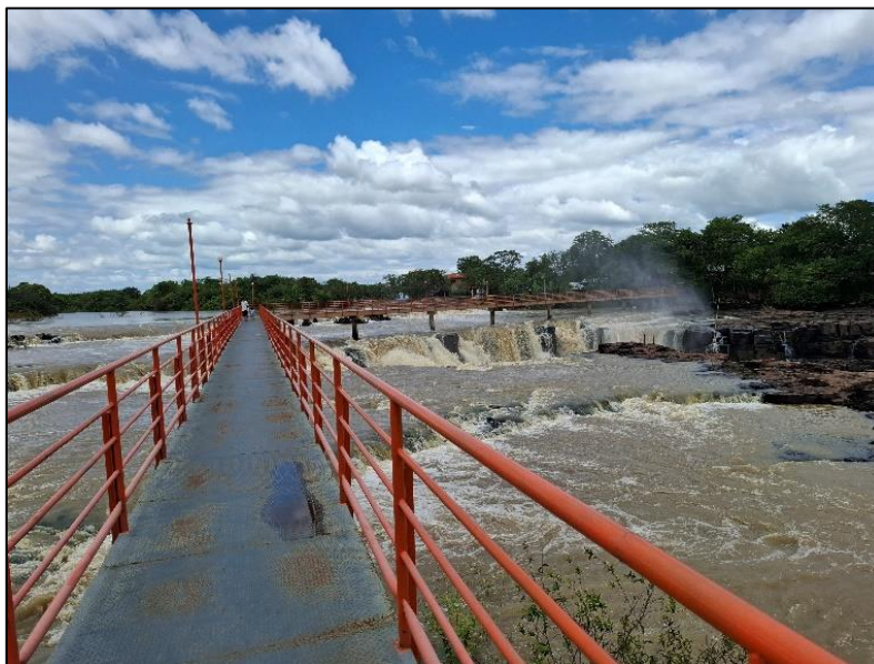
Figura 10 - Fotografia da passarela de acesso na área da Cachoeira do Urubu, Piauí. Fonte: Sousa (2024).
